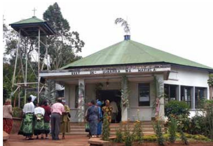
Zusammenarbeit beim Kirchengebäude in Maringa: Die tansanischen Partner bauten die Mauern, die deutschen Partner finanzierten das Dach.
